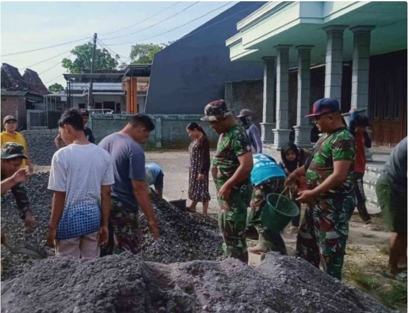
TNI Bersama Warga Gotong Royong Pembangunan Jalan Program TMMD Reguler KE-117 Di Desa Cangkring
